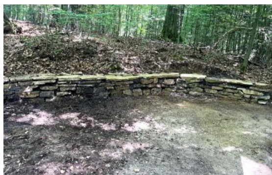
Die neu errichtete Trockenmauer
