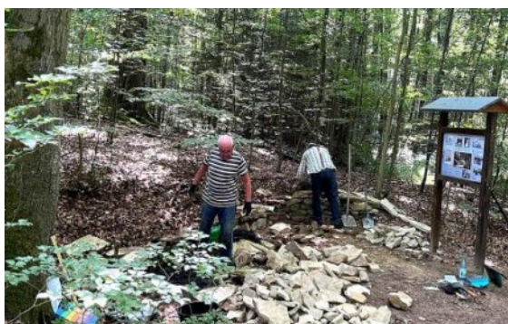
Bau der Sand-/Kalksteintrockenmauer
