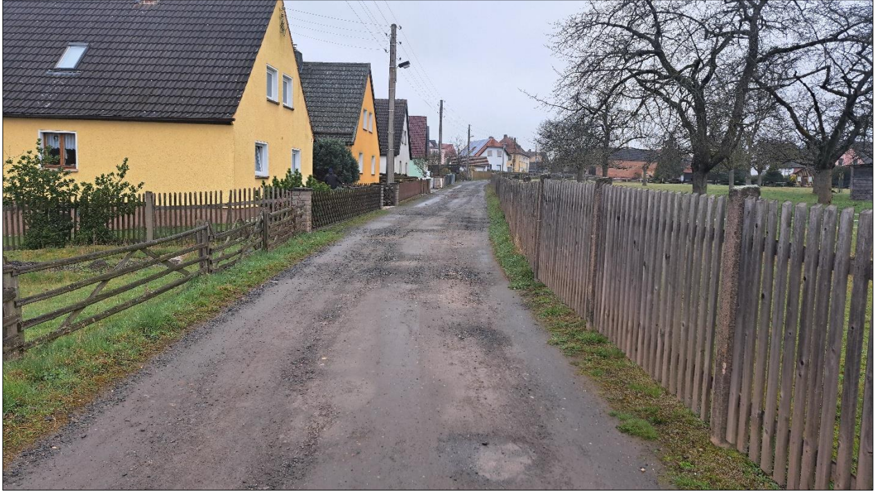
Abb. 2: vorhandene, westlich an das Plangebiet angrenzende Bebauung an der Straße „Siedlung“
