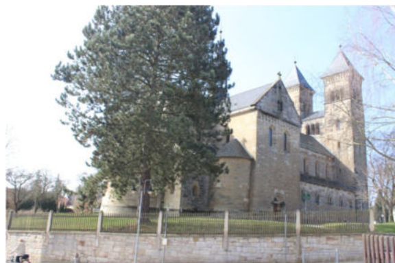
Klosterkirche mit östlichem Vorplatzbereich
