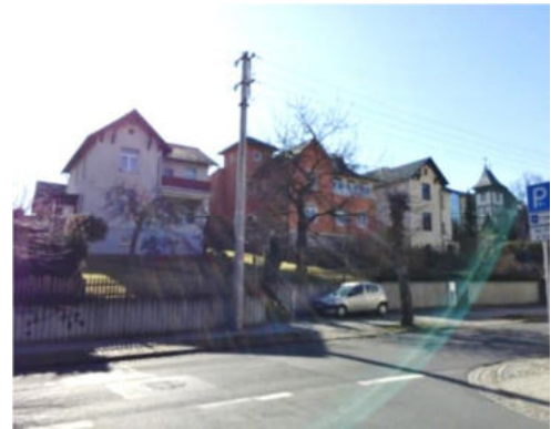
Situation heute, guter Sanierungsstand
