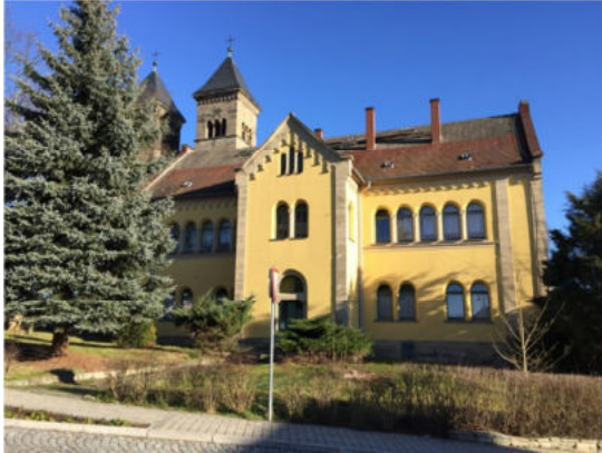
Denkmalensemble Areal um die Klosterkirche und ehem. Schule
