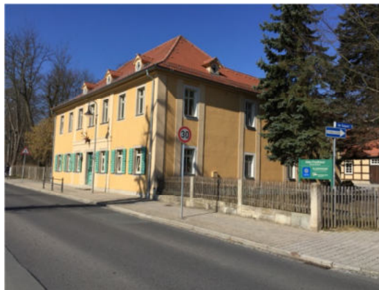
Sanierung Gehweg Jenaische Straße
