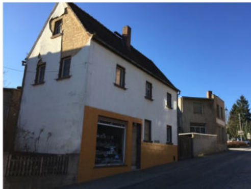
Unsanierte Gebäude, Geraer Str. 22
