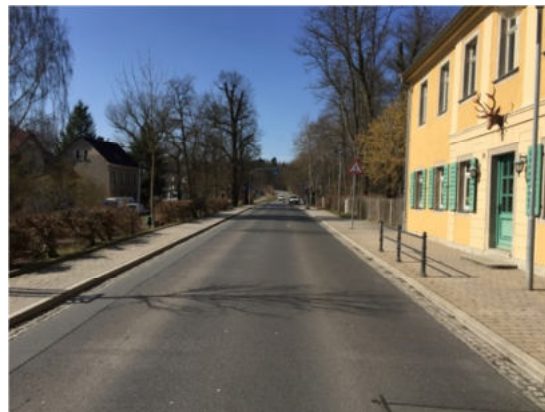
verkehrsdominierter Raum: Jenaische Straße
